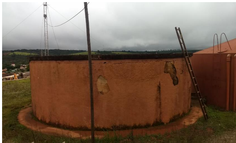
Figura 12 - Reservatório em concreto da ETA
