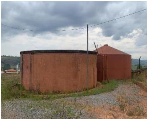
Foto 1 - Reservatório de Água Bruta
