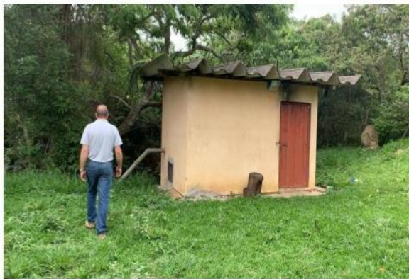
Foto 3 - Casa de bomba
