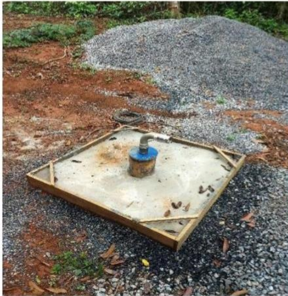
Foto 1 - Poço de Captação
