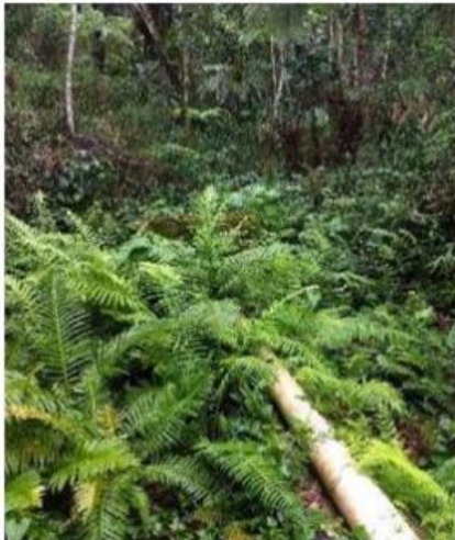
Foto 1 - Tubulação de captação da nascente
