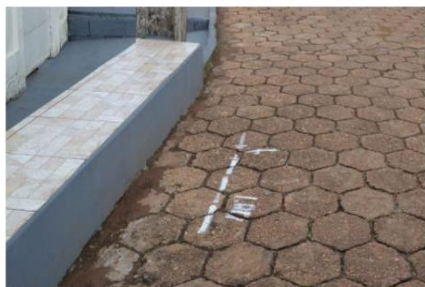
Foto 7 - Marcação em piso
