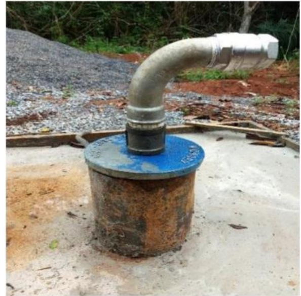
Foto 2 - Reservatório Captação Zé Mané
