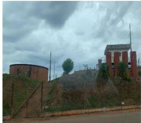
Foto 2 - Reservatório e conjunto de filtros da estação de tratamento de água
