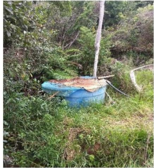
Foto 2 - Reservatório Captação Zé Mané
