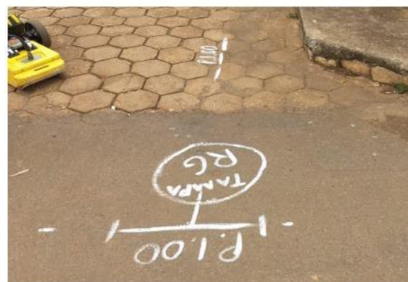
Foto 6 - Localização de rede, marcação em piso
