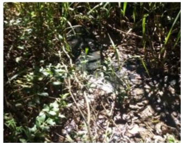
Foto 3 – Ponto de lançamento a céu aberto
