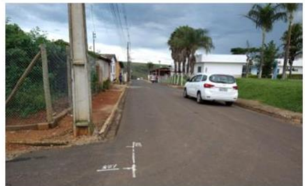
Foto 3 - Marcação na via.
