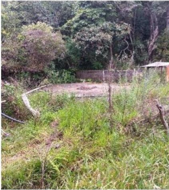
Foto 1 - Poço de Captação
