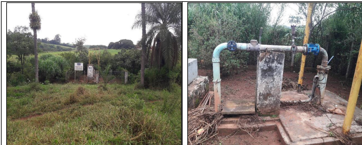
Figura 10 – Fotos realizadas durante visita preliminar – Captação
