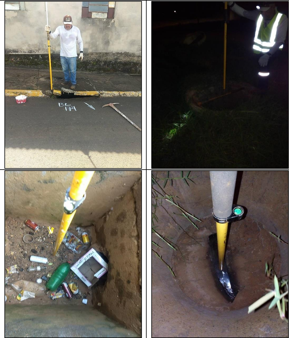
Figura 38 – Imagem referente ao registro dos serviços realizados em dispositivos de drenagem.
