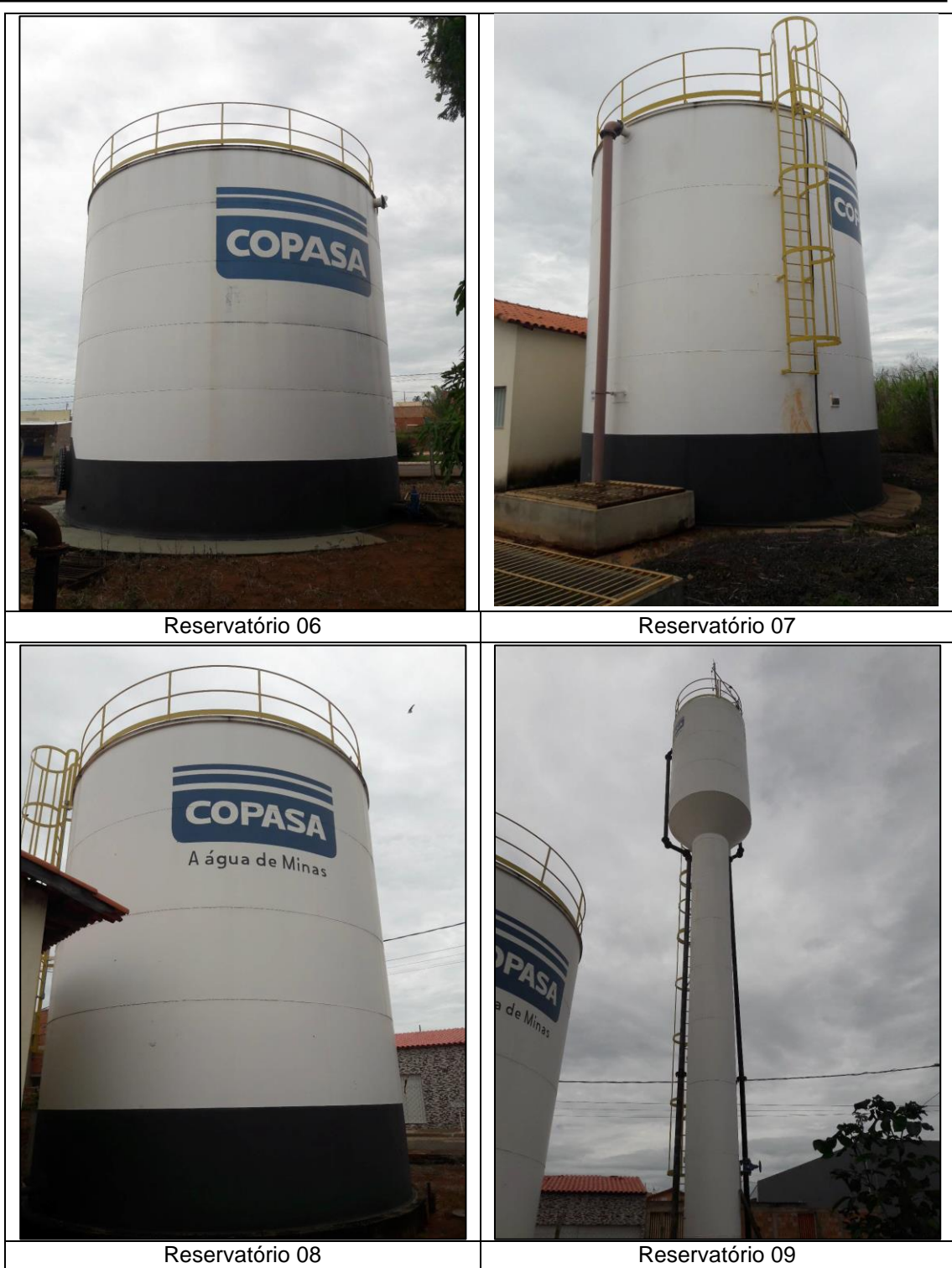
Figura 15 – Fotos dos reservatórios realizadas durante visita preliminar
