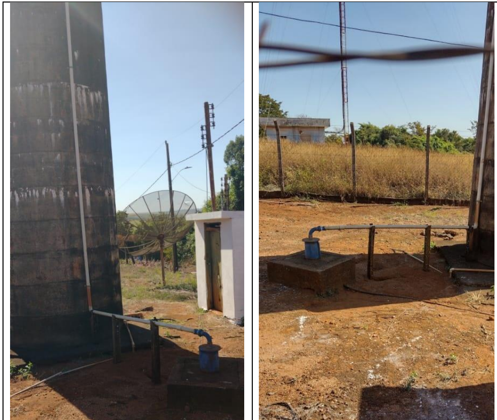
Figura 12 – Fotos realizadas durante visita preliminar – Captação
