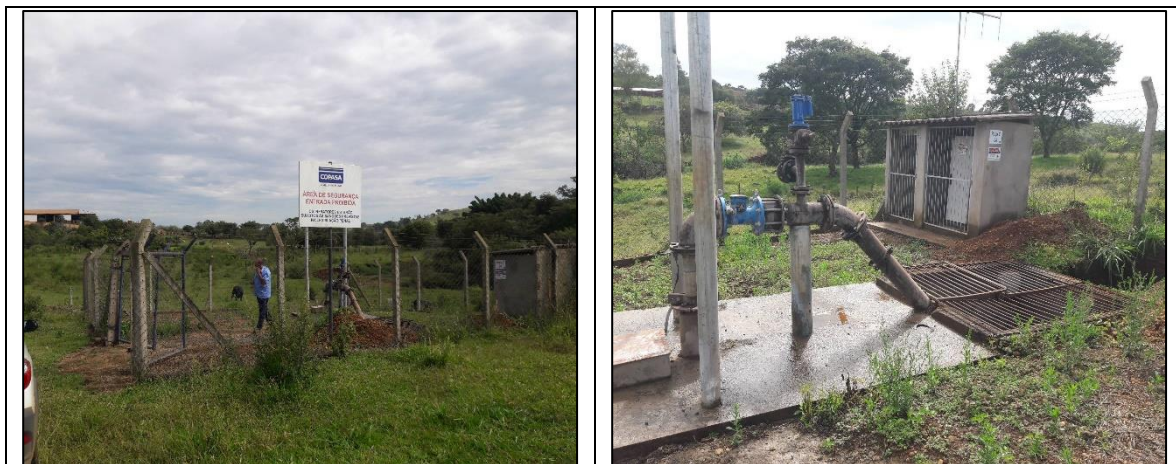
Figura 11 – Fotos realizadas durante visita preliminar – Captação
