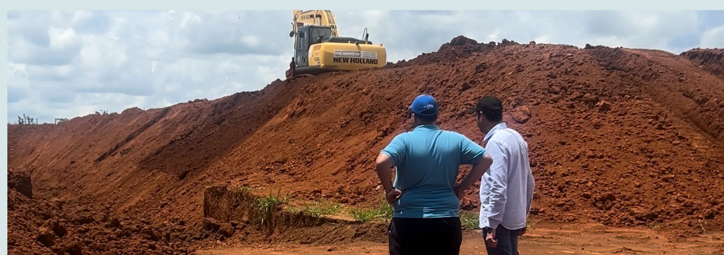
Fevereiro: Acompanhamento à obra no aterro sanitário de Santa Juliana
